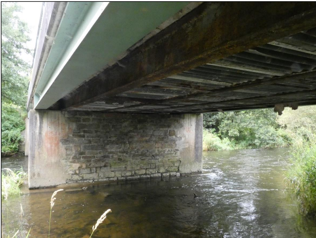
Abb. 7: Blick unter die Brücke mit Stützfeiler im Gewässer.
