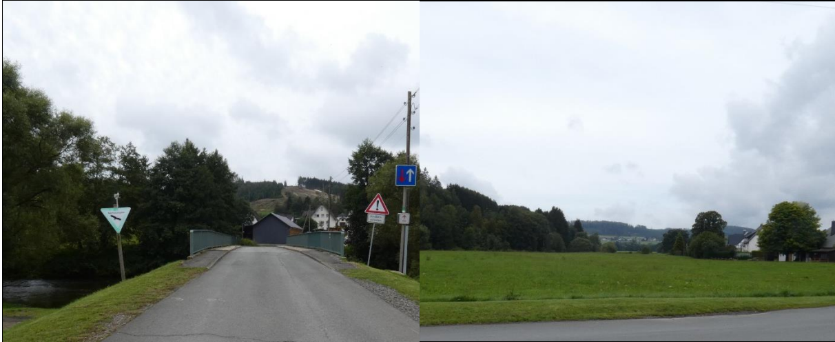
Blick auf die Ederbrücke (Blickrichtung Süd)
