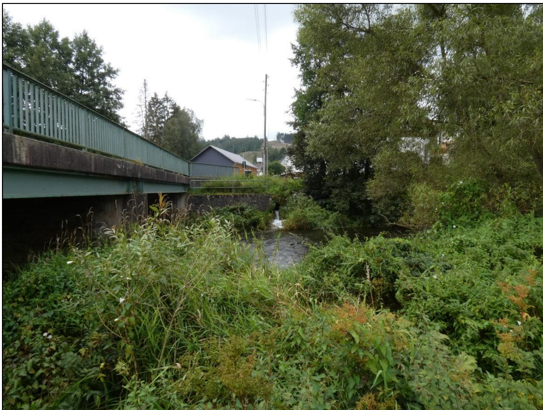
Abb. 4: Westliche Brückenseite (Blickrichtung Süden), Bereich, in dem die temporäre Behelfsbrücke hergestellt wird.
