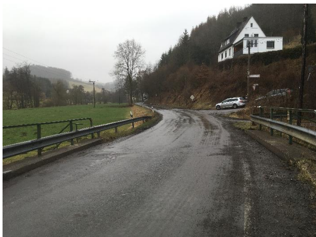
Foto 1: L 877 Bereich Brücke, in Stationierung
