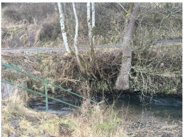
Foto 9: Elsoff unterhalb Brücke, Böschung links
