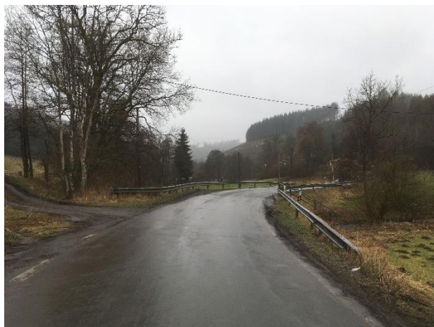
Foto 2: L 877 Bereich Brücke, gegen
