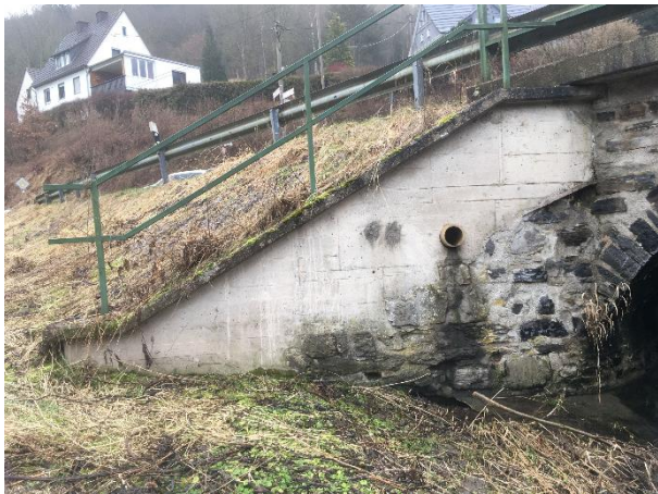
Foto 5: Oberwasser, Flügelwand links
