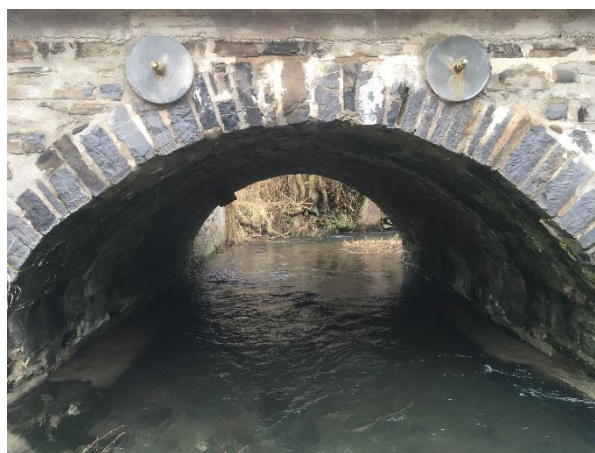
Foto 4: Brücke, Gewölbe in Fließrichtung
