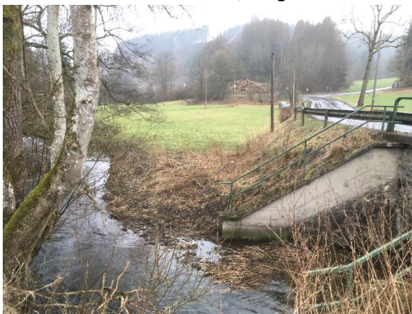
Foto 8: Elsoff unterhalb Brücke, Flügelwand rechts
