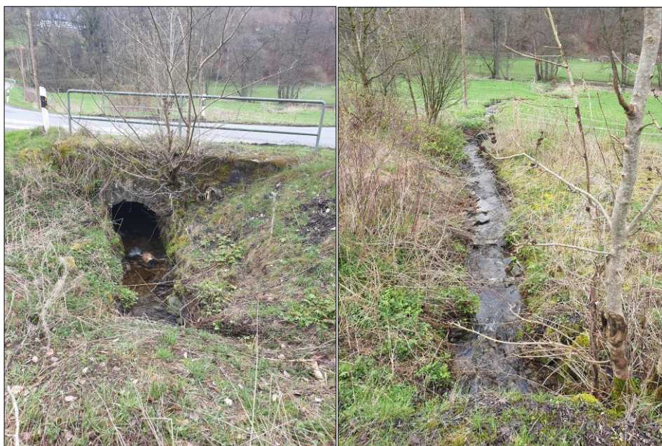
Abb. 6 Garsbachdurchlass gemauert Garsbach unterhalb des Durchlasses
