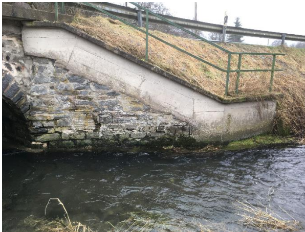
Foto 6: Oberwasser, Flügelwand rechts
