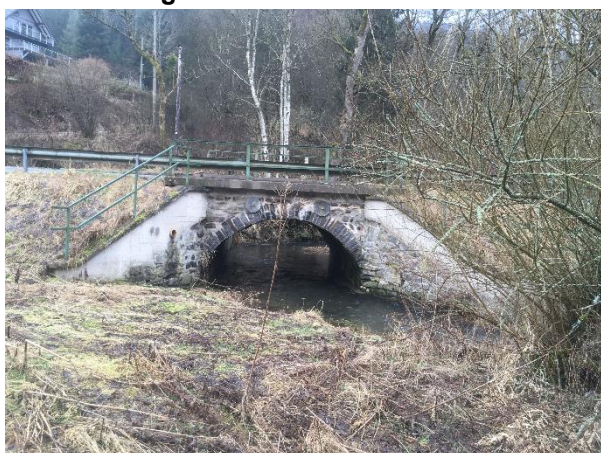
Foto 3: Brücke, Flügelwände von Oberwasser
